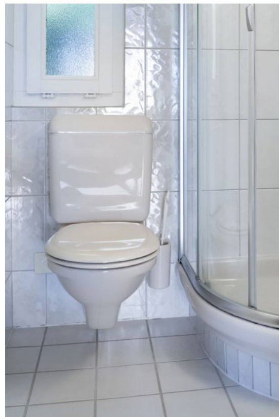
↑ VORHER Herkömmliches WC mit Aufputzspülkasten.
